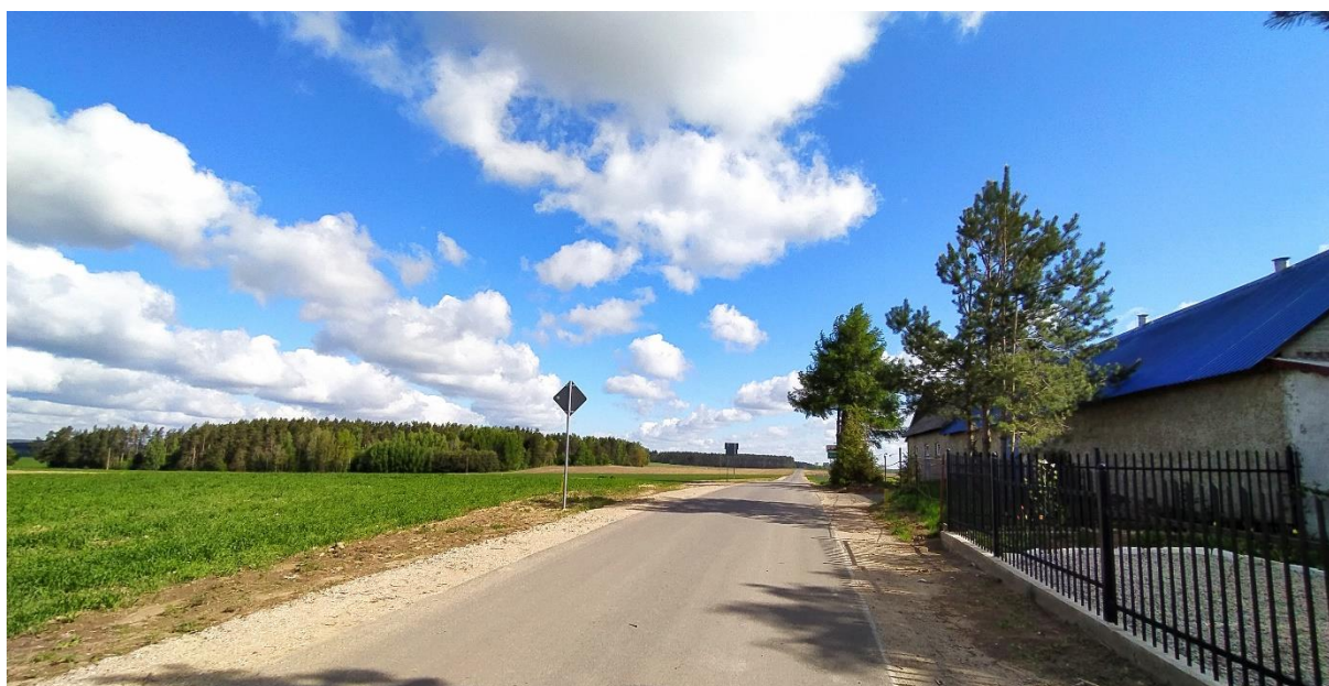
Fot. 5 Przebudowany odcinek drogi w m. Dołęgi.
