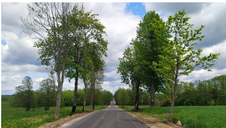
Fot. 1. Droga gminna Czarnówek – Niedźwiadna (w budowie)
