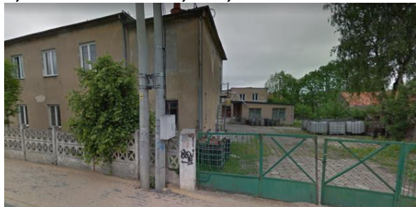
Rys 12. Stan techniczny budynków na obszarze rewitalizacji – Spółdzielnia Inwalidów „SPINS”
