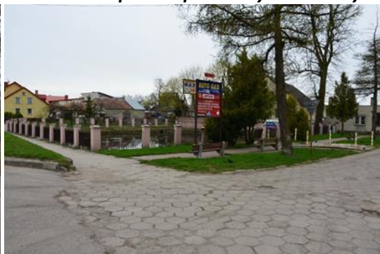
Fot. 2 Zbiornik przeciwpożarowy w Szczuczynie
