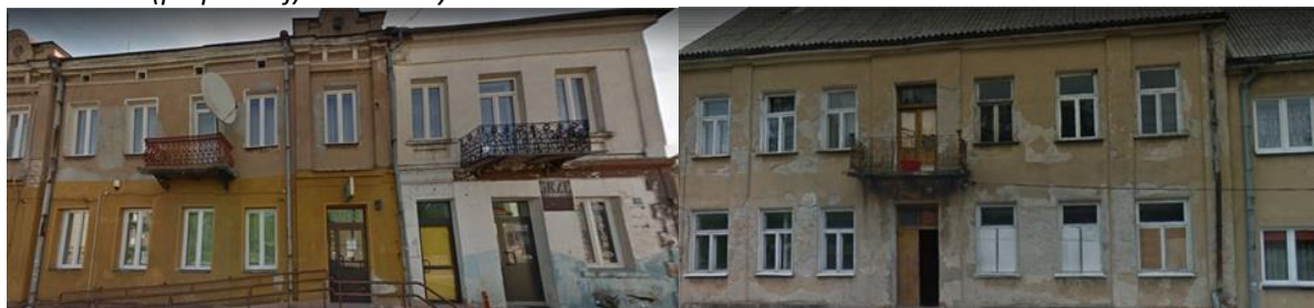
Rys. 3 Stan techniczny budynków na Podobszarze I rewitalizacji - ul. Kilińskiego (po lewej) i Rys 4. Plac 1000-lecia (po prawej) w Szczuczynie.
